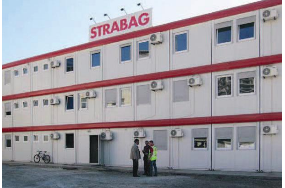
Oficina de obra
